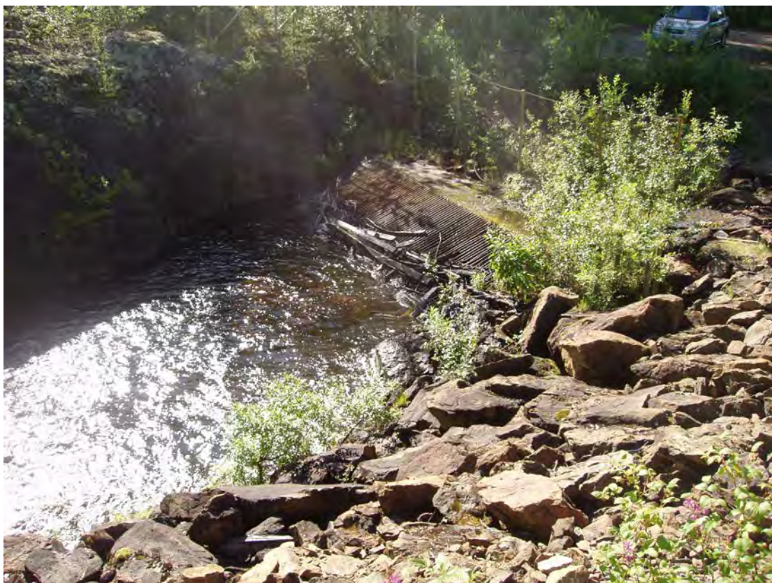
Foto 11. Kaltibäckens inlopp i tunneln som leder vattnet uppströms Messaures kraftverk. Foto: Patrik Olofsson, Länsstyrelsen, 2007.
